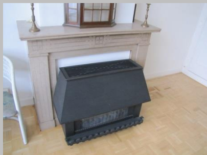
Individuele gaskachels in verblijfsruimten
