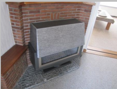
Individuele gaskachels in verblijfsruimten
