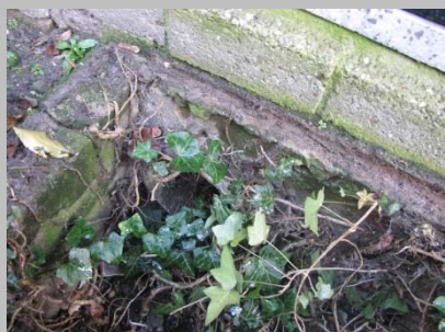
Beluchtingspijp vrijmaken en ontdoen van vervuiling
