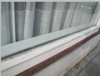
Aangetaste neuslat voorgevelpui
