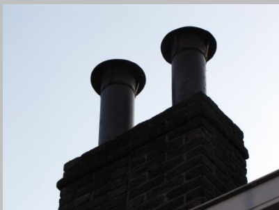
Asbestverdachte schoorsteenkanalen
