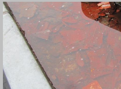
Het zink raakt aangetast door bladzuren en wordt dun
