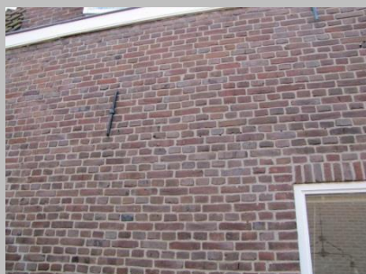
De smeedijzeren gevelankers zijn in goede conditie
