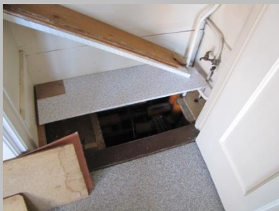
De enige toegang tot de kruipruimte
