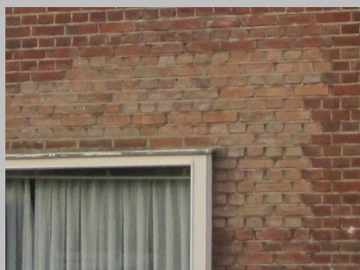
Aftekeningen in het metselwerk duiden op gevelwijzigingen
