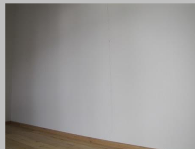
Haarscheurvorming door thermische lengteverandering
