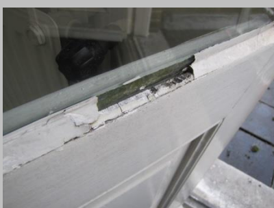
Loskomende en ontbrekende stopverf
