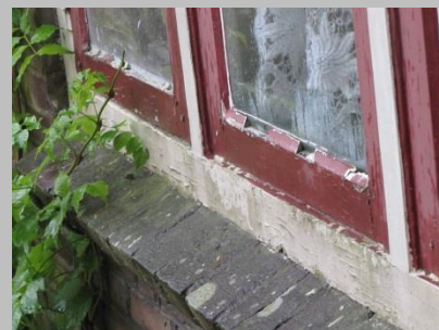
Regelmatig klemmende delen en losgeraakte stopverf
