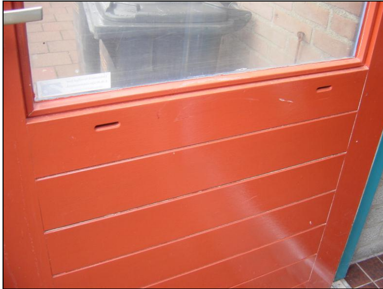
19. deur hangt andersom, afwateringsgaten zitten binnen
