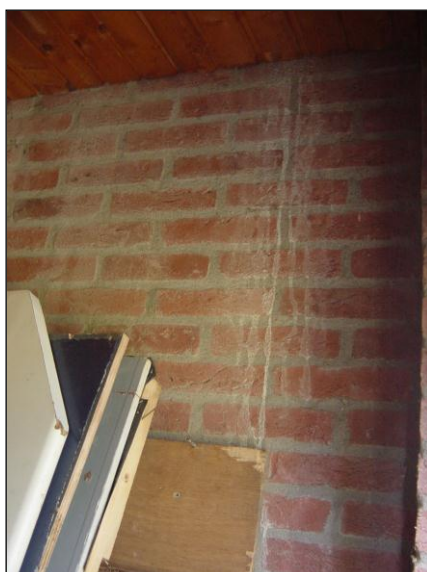
12. blijvende vervuiling op binnenmetselwerk
