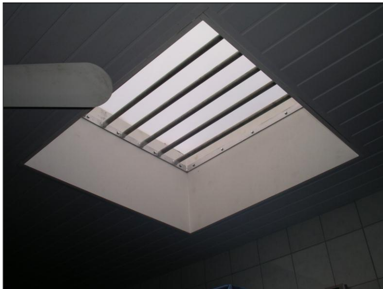
22. inbraakbeveiliging is keurig aangebracht
