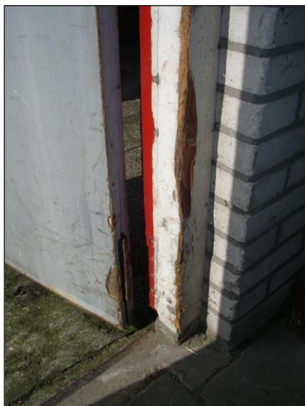
23. kozijn mist een scharnier
