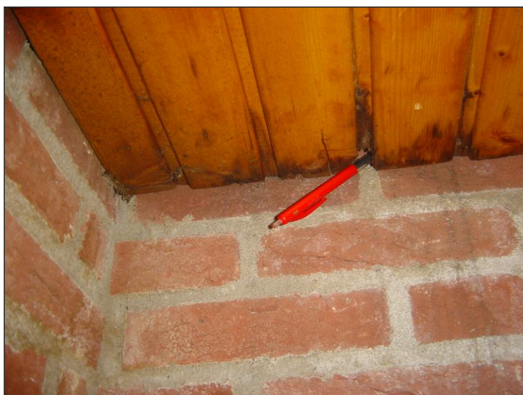
33. schrotenplafond is in zeer matige staat
