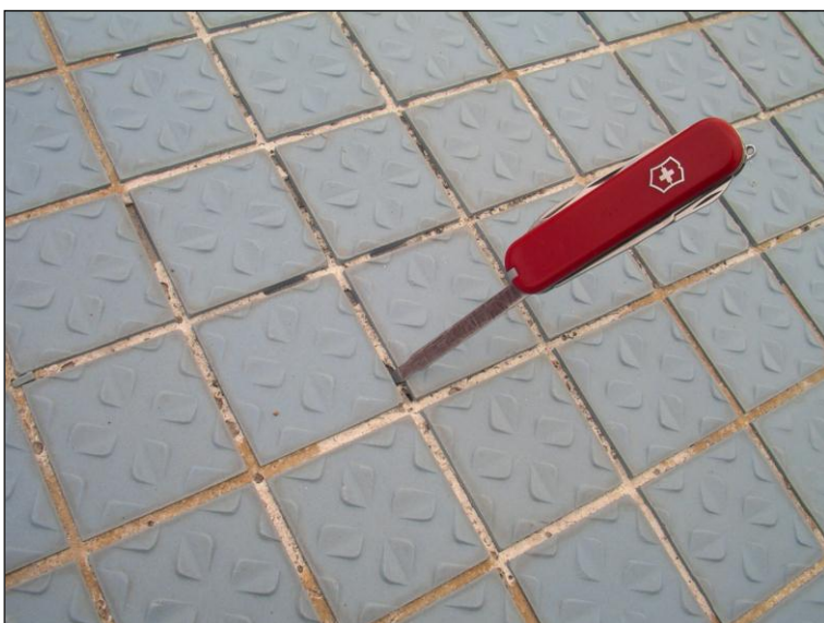
29. diep ingesleten of ontbrekend tegelvoegwerk
