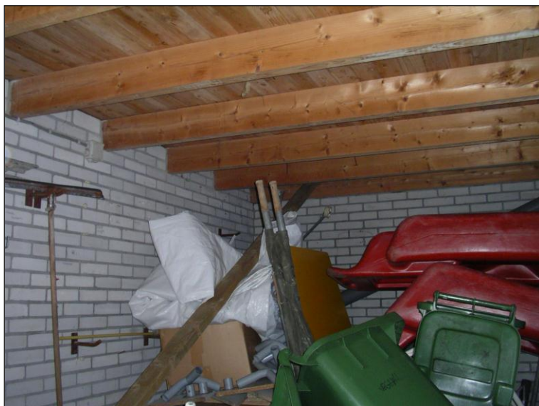
14. houten balklaag in goede staat
