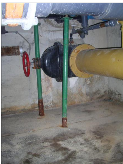
30. gecorrodeerde opvangconstructies
