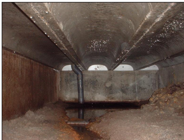
3. mangaten onder de funderingsbalken onder water
