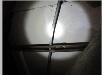
Parallel lopende koud- en warm waterleidingen
