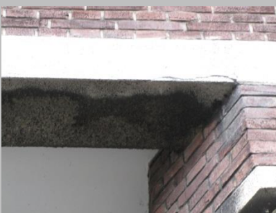
Haarscheuren en afschilfering aanwezig
