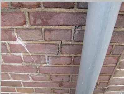
Geringe spannings-scheurvorming en schraal voegwerk
