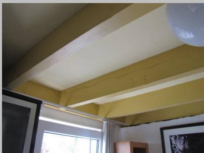
Platbalklaag in zicht vanaf zolders
