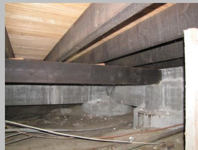
Kruipgedeelte naast kelder is in goede staat
