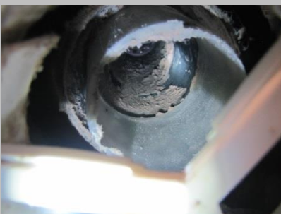
Loze- en gemotoriseerde afzuigpunten regelmatig reinigen
