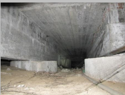
Putten- en balkenfunderingen in goede staat
