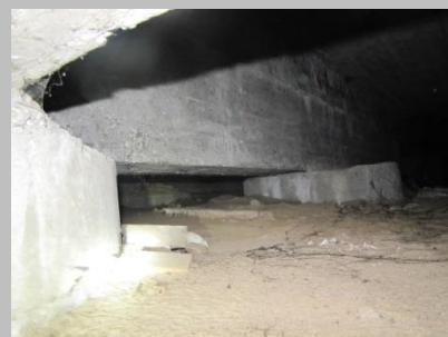
Putten- en balkenfunderingen in goede staat
