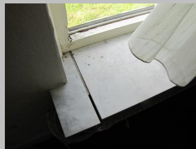
Los liggende vensterbanken gezamenlijke bijkeuken
