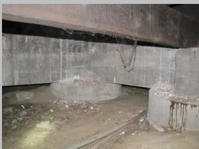
Putten- en balkenfunderingen in goede staat
