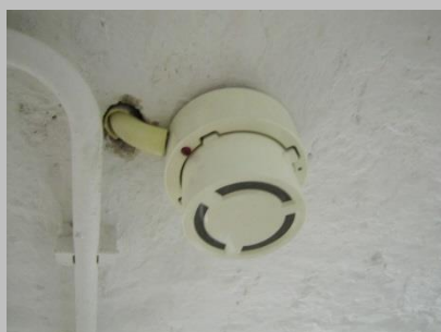
Ioniserende rookmelder (inmiddels verboden)
