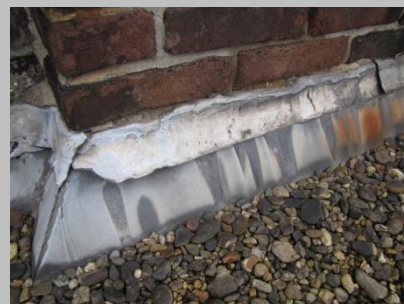
Dun geworden zink, gescheurde loodslabben, spoorvorming
