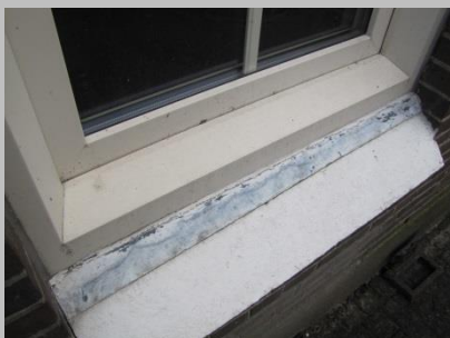
Elastische afdichtingen links en rechts van dorpel maken
