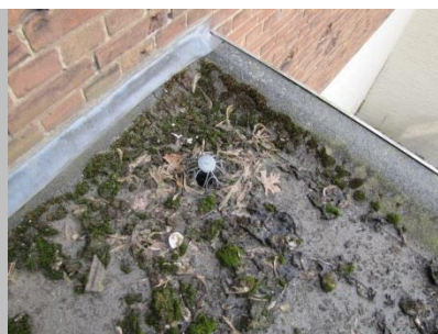
dakvlak op overkappig reinigen
