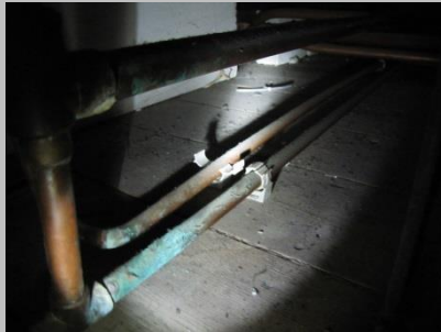
Parallel lopende koud- en warm waterleidingen
