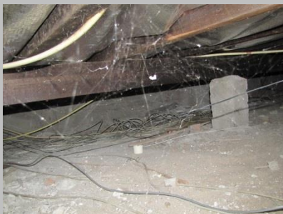
Kruipruimtebodem is droog, electra structureren
