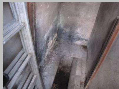
Wanden in berging opnieuw berapen en berging ventileren
